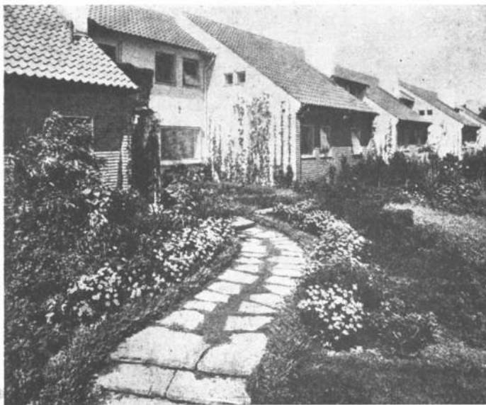
La ciudad de Friluftsstaden (ciudad al aire libre), en Malmo. Casas en fila alternadas, proyectadas y construidas por Erik Sigfrid Persson. Todas las casas enfrentan un patio rectangular formado por las partes salientes; los patios, a su vez, abren sobre el parque común.
