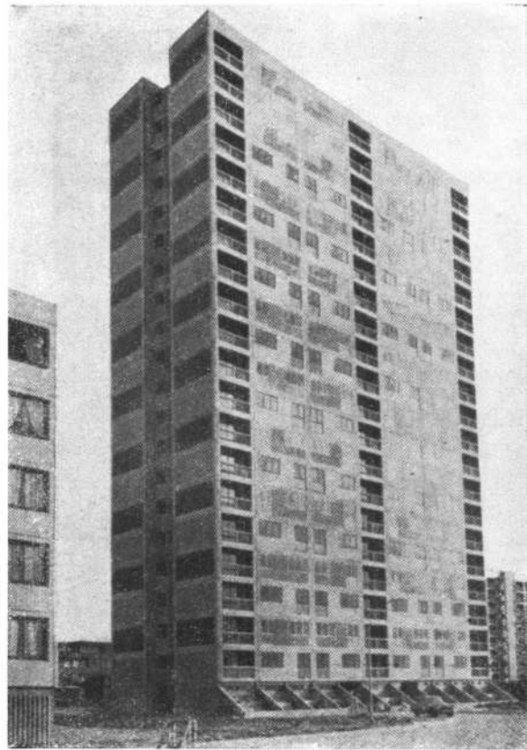
Torre de 20 pisos proyectada por Heaume y Perutz y construida por Camus en Maisons-Alfort exhibiendo la mayoría de las características de este "padre" del sistema francés de construcción del boom (auge repentino) de post-guerra.
