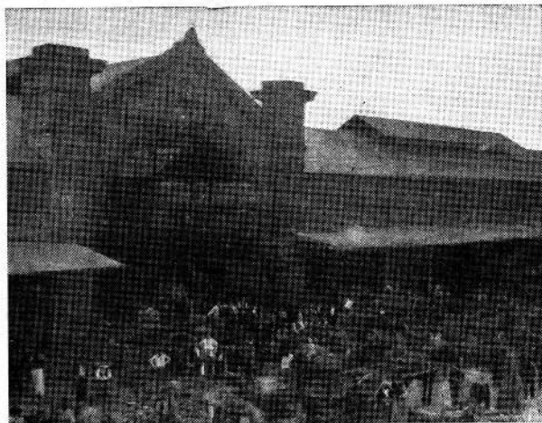
Viejo Mercado de Abasto (1925). Edificio que cubre parcialmente el lugar de acopio y distribución minorista de verduras, frutas, etc., provenientes de la zona semirural circundante.
