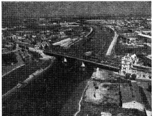
Abajo: Riachuelo a la altura de Nueva Pompeya. Puente Teniente General José F. Uriburu. El curso del río ha sido rectificadado desde este puente hacia el S.O., es decir, hacia el fondo de esta vista, con el fin de obtener una regularidad en el cauce y una pendiente mayor que favorezca el escurrimiento de las aguas; sin embargo, esto no ha sido logrado debido principalmente a que las industrias vecinas arrojan todos sus desperdicios estancando cada vez más las aguas del Riachuelo.
