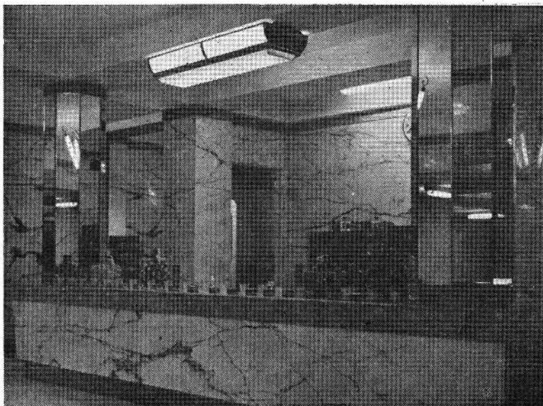
Bar lácteo en el túnel que comunica a la Ciudad Infantil con la Ciudad Estudiantil.
