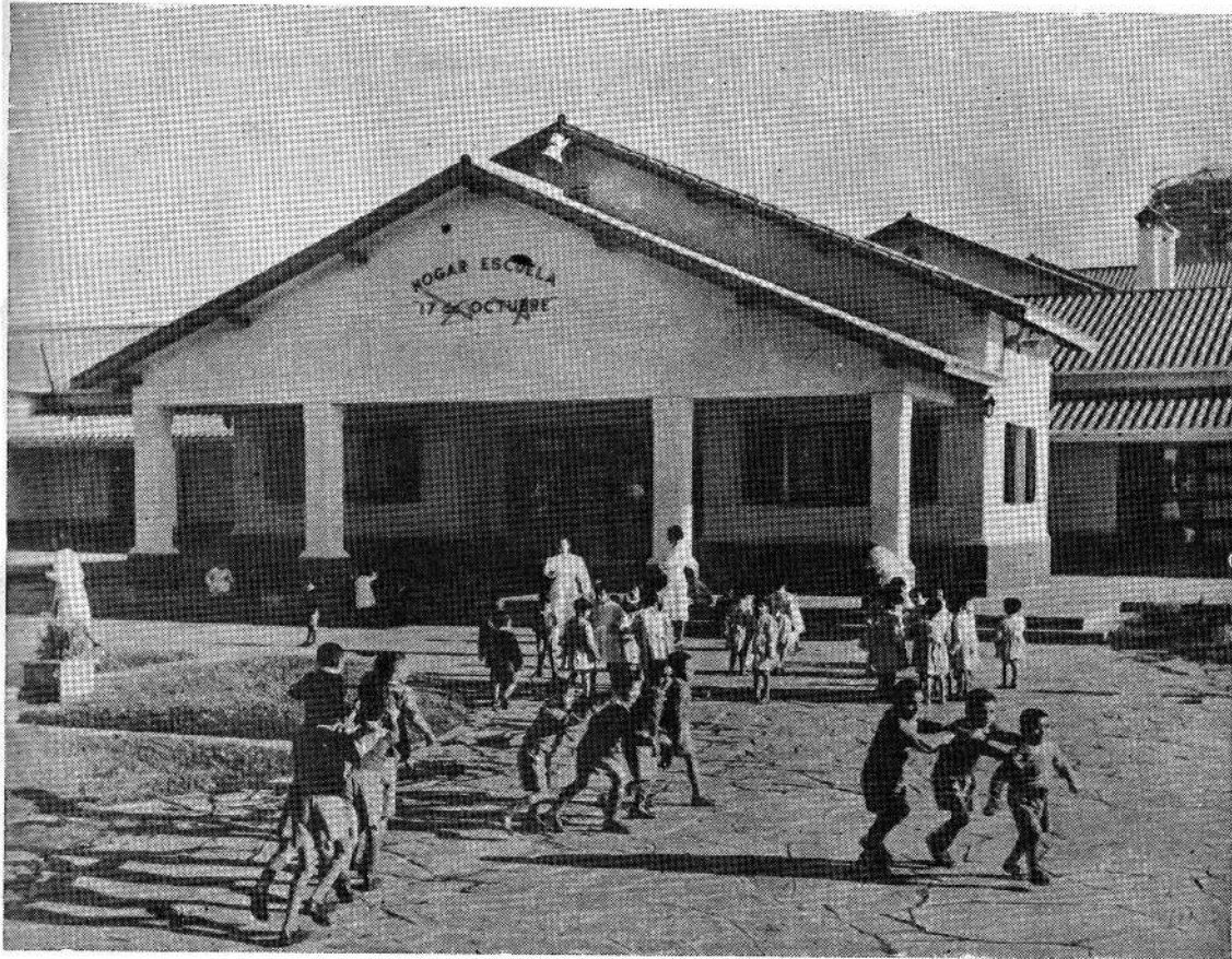
Patio de ingreso al Hogar Escuela 17 de Octubre
