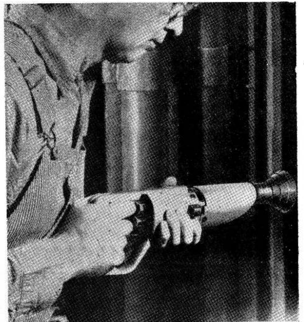
14. — Revólver Remington, para clavar con la rapidez y la seguridad de un tiro, en todo material.
