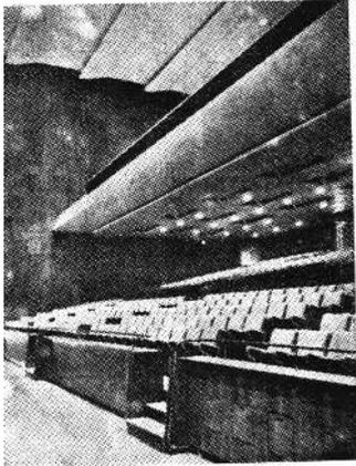
Vista desde la cabina de proyección. Entre los asientos de primera fila y la plataforma de la orquesta puede verse el espacio cubierto de losas reflectoras del sonido.
