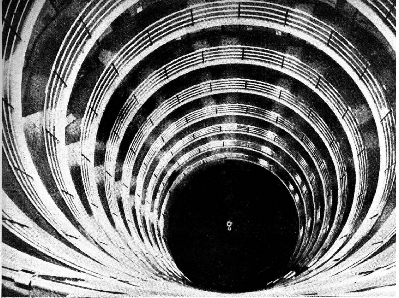
Albergue de los obreros de la "Fiat", en Sestrières
