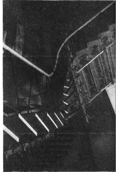
Tramo de la escalera suspendida con estructura tubular.
