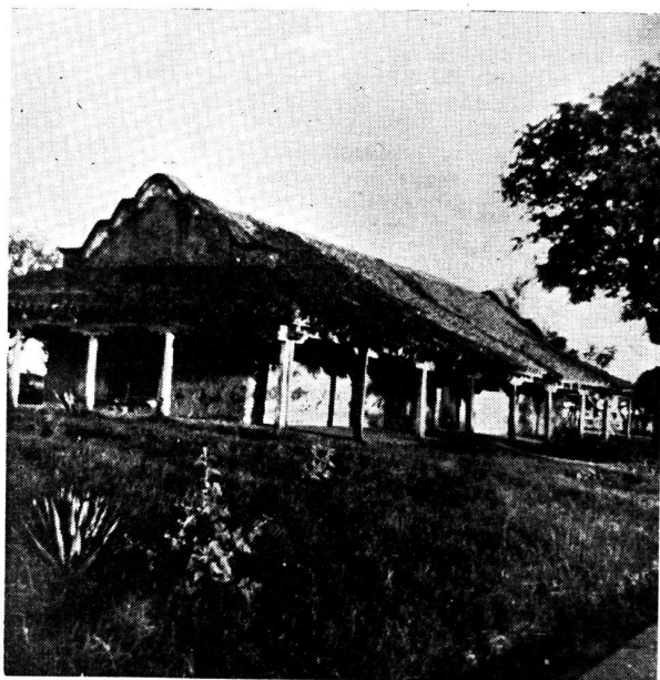
Vista del costado Norte y Fachada Este.
