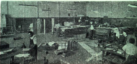
FABRICACION DE CONDUCTOS
