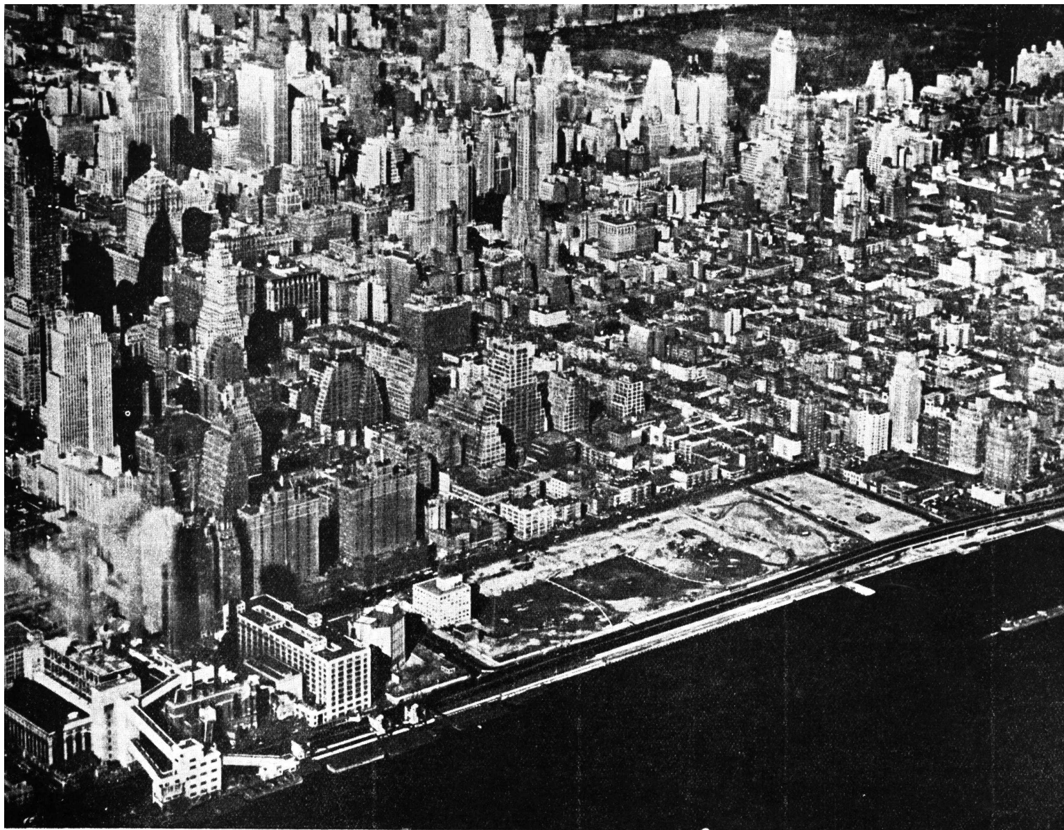
Vista de Nueva York, sobre la costa del East River, mostrando el gran solar donde se levantarán los edificios para la sede de la U.N., ya terminadas las obras de demolición y limpieza de las construcciones que existían allí
