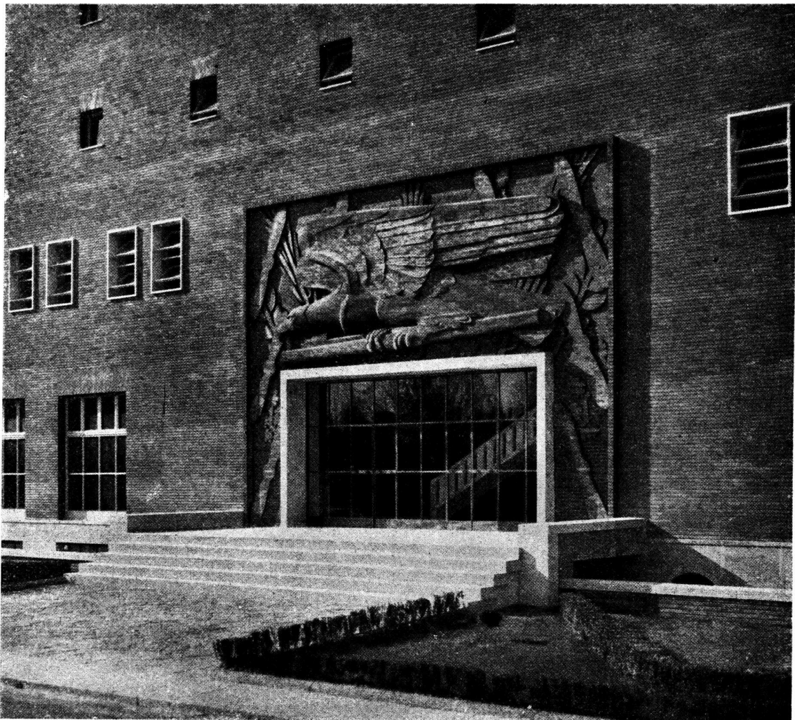
Entrada principal del edificio de Alojamiento de los alumnos, con portón esculpido en ladrillos. Obra de Mario Moschi
