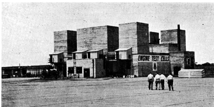
FIG. 21 - Aspecto exterior de un edificio con cuatro bancos de ensayo de motores.
