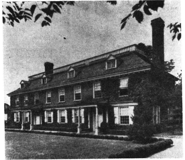
Con frecuencia, por carecer de habilidad o de las herramientas para trabajar la piedra, los constructores norteamericanos utilizaban la madera para los detalles decorativos, aunque las paredes fuesen de ladrillo. Philipse Manor, Yonkers, cerca de Nueva York, 1750, es un ejemplo de ello.
