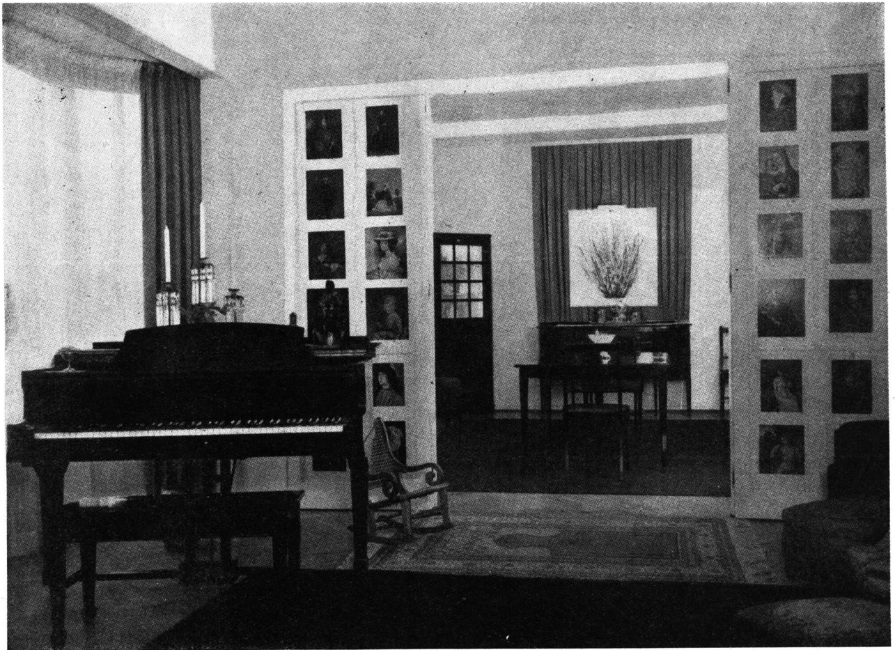
Vista hacia el comedor del 5º piso.
