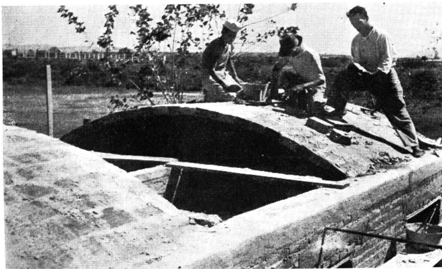
Detalle de la cimbra de un metro de ancho.
