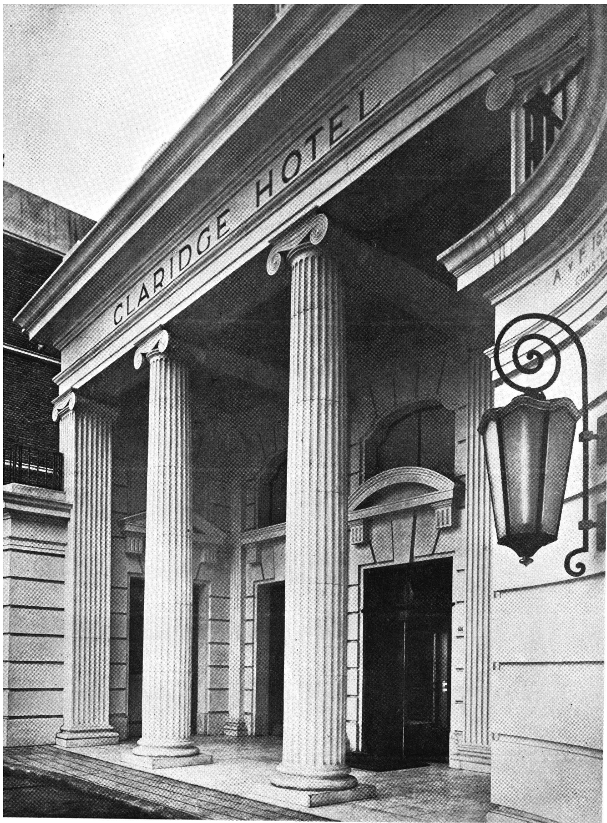
VISTA DE LA ENTRADA PRINCIPAL
