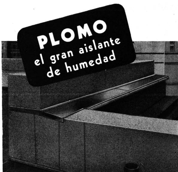
Una babeta de plomo con junta de dilatación da un corte final a todo riesgo de filtraciones, sin límite de tiempo.
