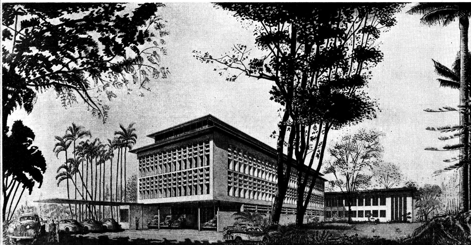
Frente posterior de la Fábrica. Al fondo, el edificio de la Administración.
