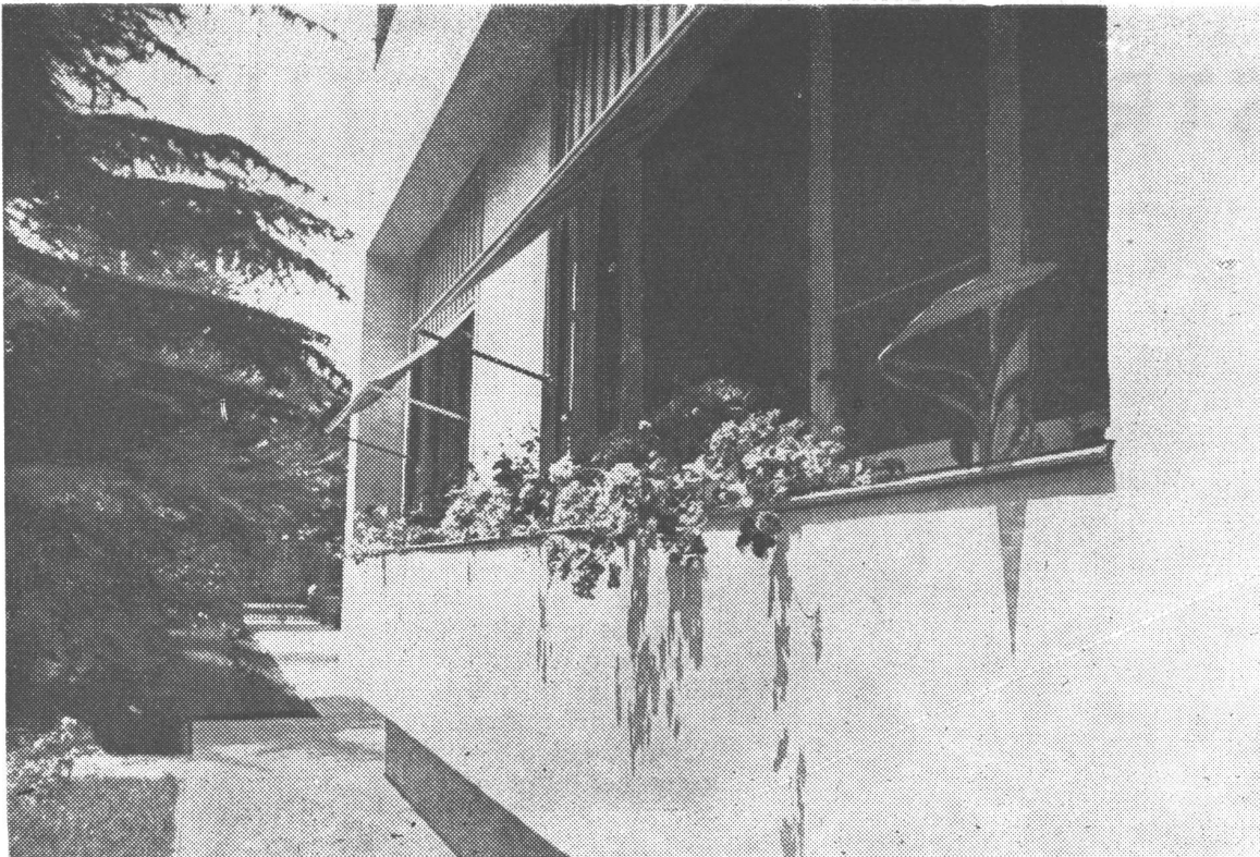
Detalle de la fachada. Zócalo de "cuarzite" gris olivá. Toldos de lona a fajas verde y marfil con enrolladores maniobrados desde el interior.
