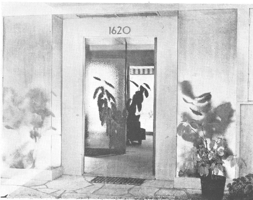
La entrada principal con plantas detrás de vidrios opacos. Vista dentro del vestíbulo de entrada.
