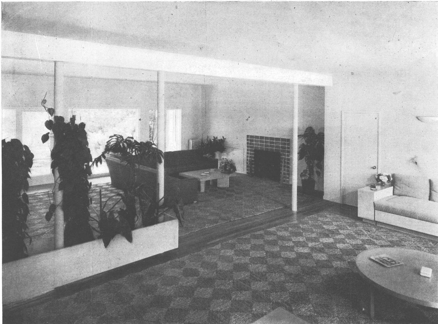
La pared estructural entre el jardín de invierno y el living room fué reemplazada por una viga y delgadas columnas de caño. Arriates colocados en la línea divisoria de los ambientes sirven para dirigir la circulación sin separar los locales.
