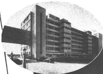
Ventanales de hormigón armado "Verlit" hijos y con balancines del mismo material, accionados con molinillos de bronce. Los ventanales cubren una superficie de 5.100 m<sup>2</sup>. Construidos y colocados por la firma F Arntsen, empleando exclusivamente cemento "INCOR".
