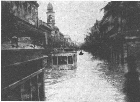
Tranvías "navegando" en la calle Olavarría durante una de las periódicas inundaciones de la zona.
