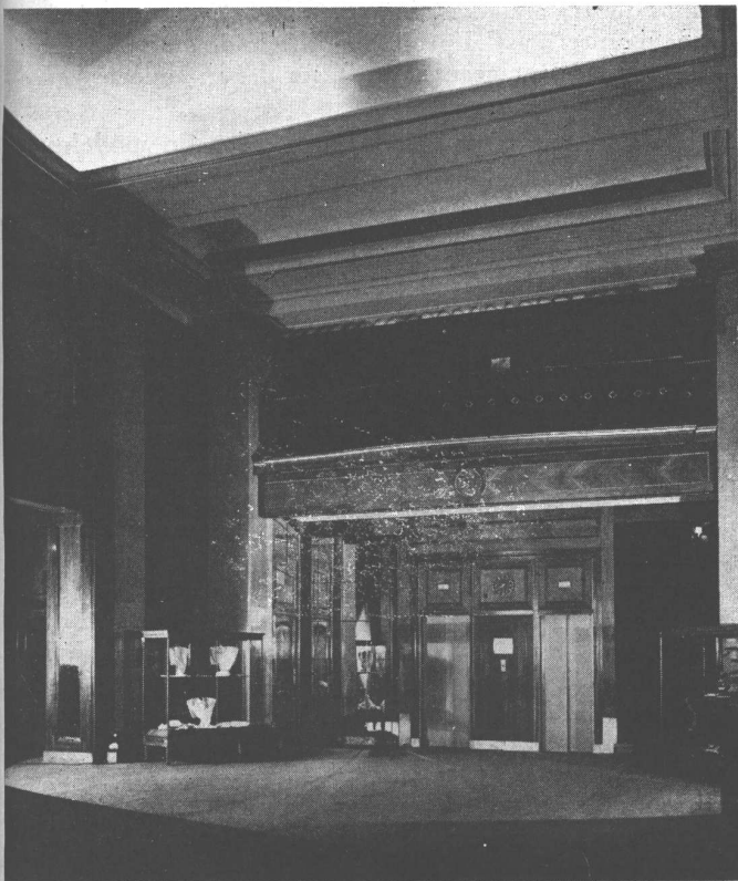
DETALLE DEL HALL
