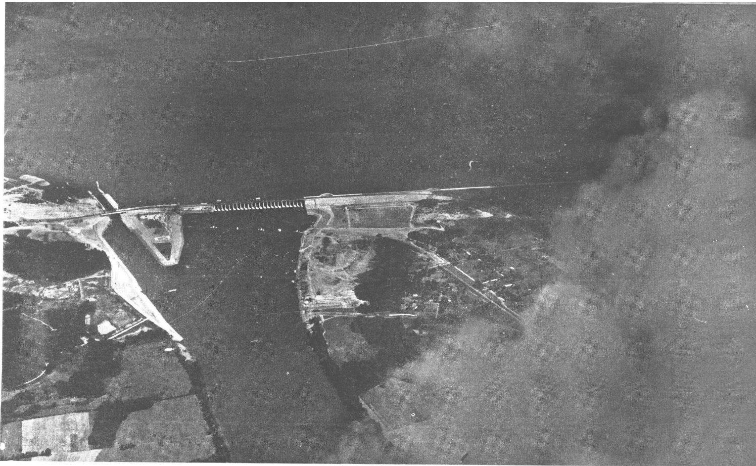
De izquierda a derecha: bahía para embarcaciones de paseo (sobre el lago); esclusa de navegación; bahía para atar o soltar los remolques (río abajo); edificio de control y tableros (en el islote); usina; vertedero; dique rellenado con tierra, con estacionamiento del lado del lago y camino ferroviario del otro lado.
