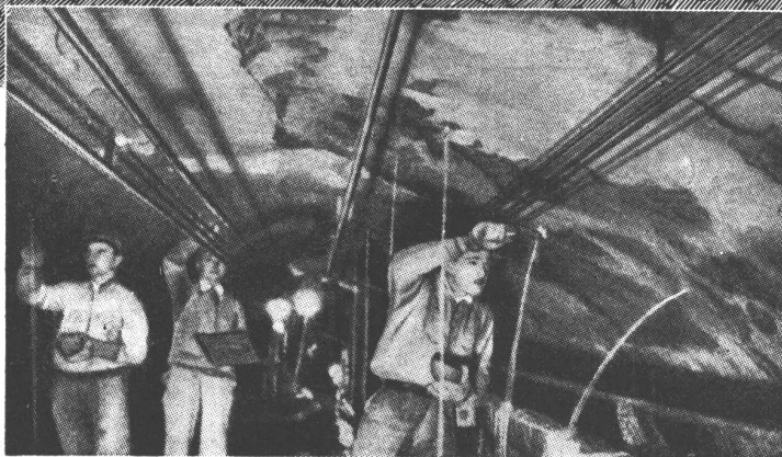
Impermeabilización con SIKKA: - Suprimiendo chorros de agua bajo fuerte presión.
