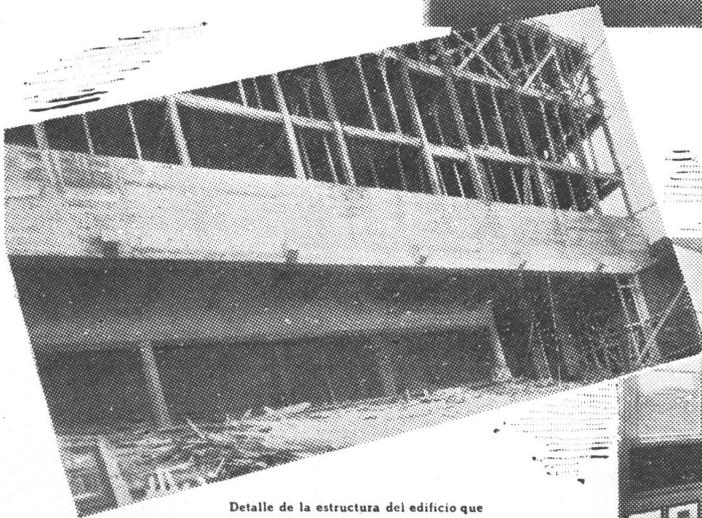
Detalle de la estructura del edificio que permite apreciar la importancia de los trabajos realizados entre los cuales se destaca la construcción de una viga de hormigón de 26 metros de luz.
