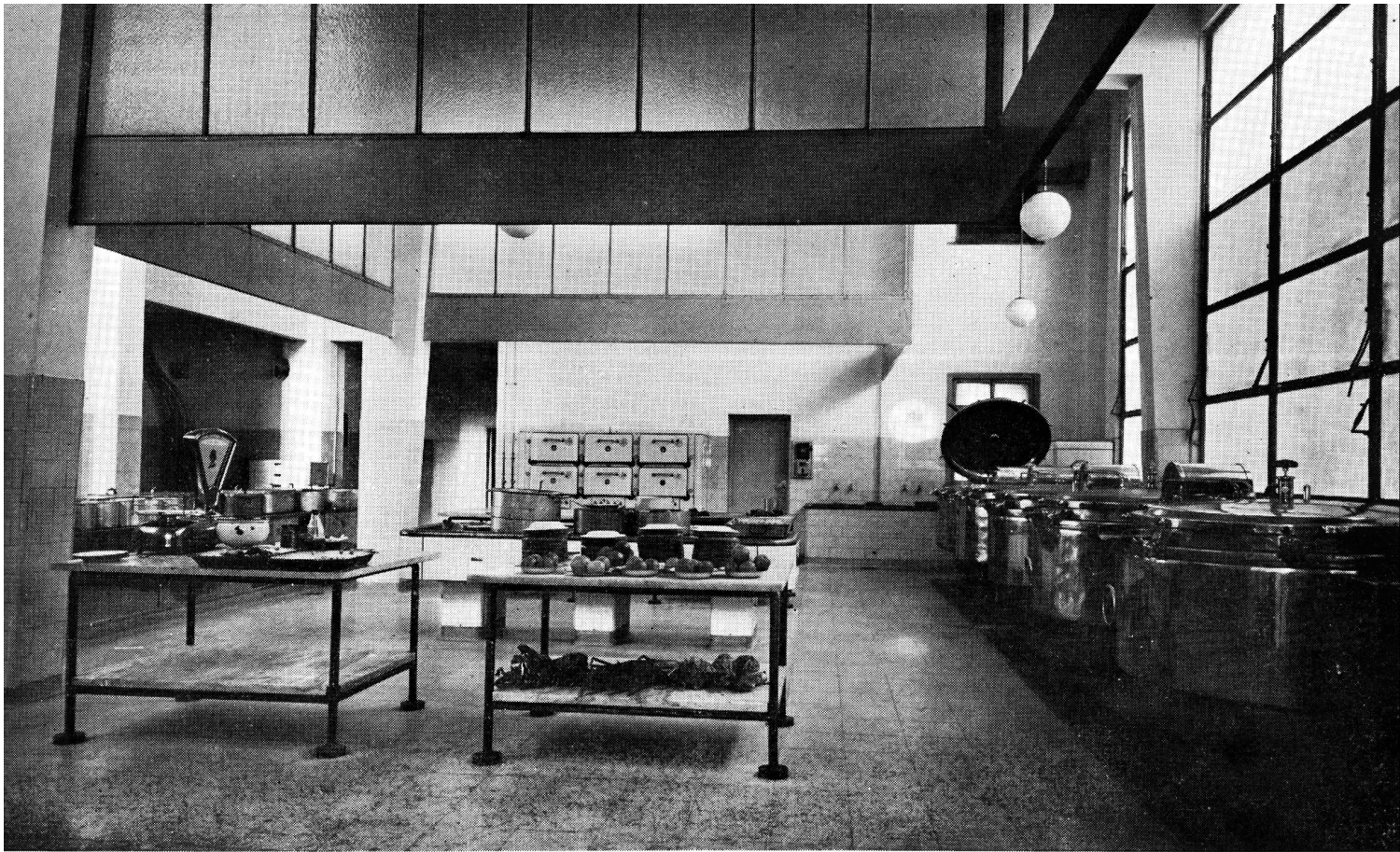
Vista de la cocina.
