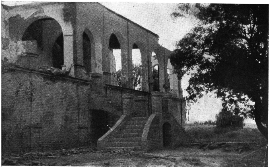
Casa Administración de una vieja bodega.
