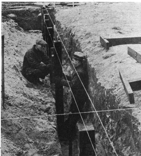
Detalle del cimiento de la casa del Laboratorio: pilotes y solera de madera creosotada
