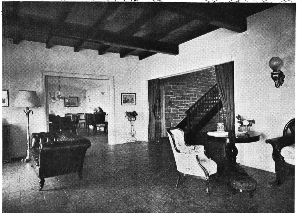
Vista desde el living hacia el comedor y hall de entrada. Cielorraso del comedor, armado en metal desplegado, siguiendo la curva de la parte superior de la estufa. La pared de la estufa, es con los ladrillos a la vista y blanqueados. La puerta que separa el living del comedor es de tablillas y corrediza.
