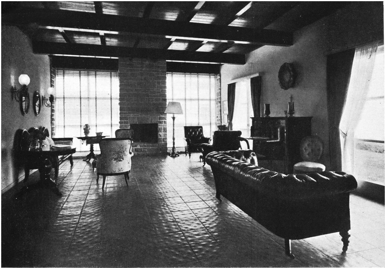
Vista del living hacia la chimenea. Piso cerámico colonial de 30x30. Paredes pintadas a la cal. Entrepiso de madera según detalle. Chimenea de piedra amarilla con junta blanca y amplios ventanales fijos con cortinas «Airflow». Puertas al exterior corredizas.
