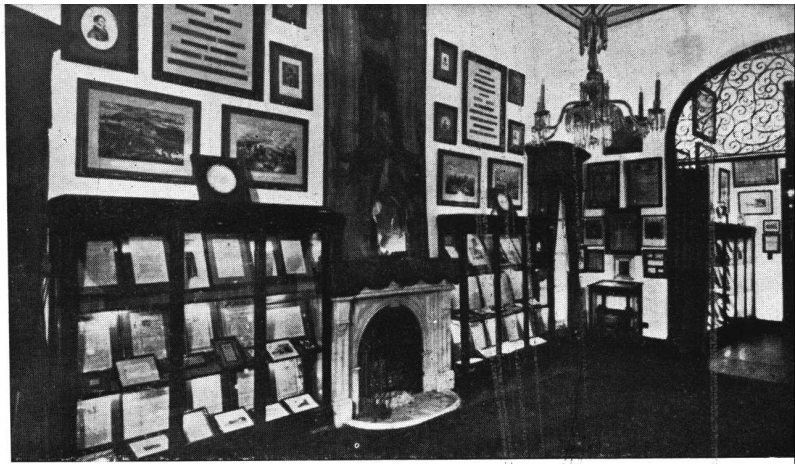
VISTA PARCIAL DE UNA DE LAS SALAS DE LA TIRANIA
