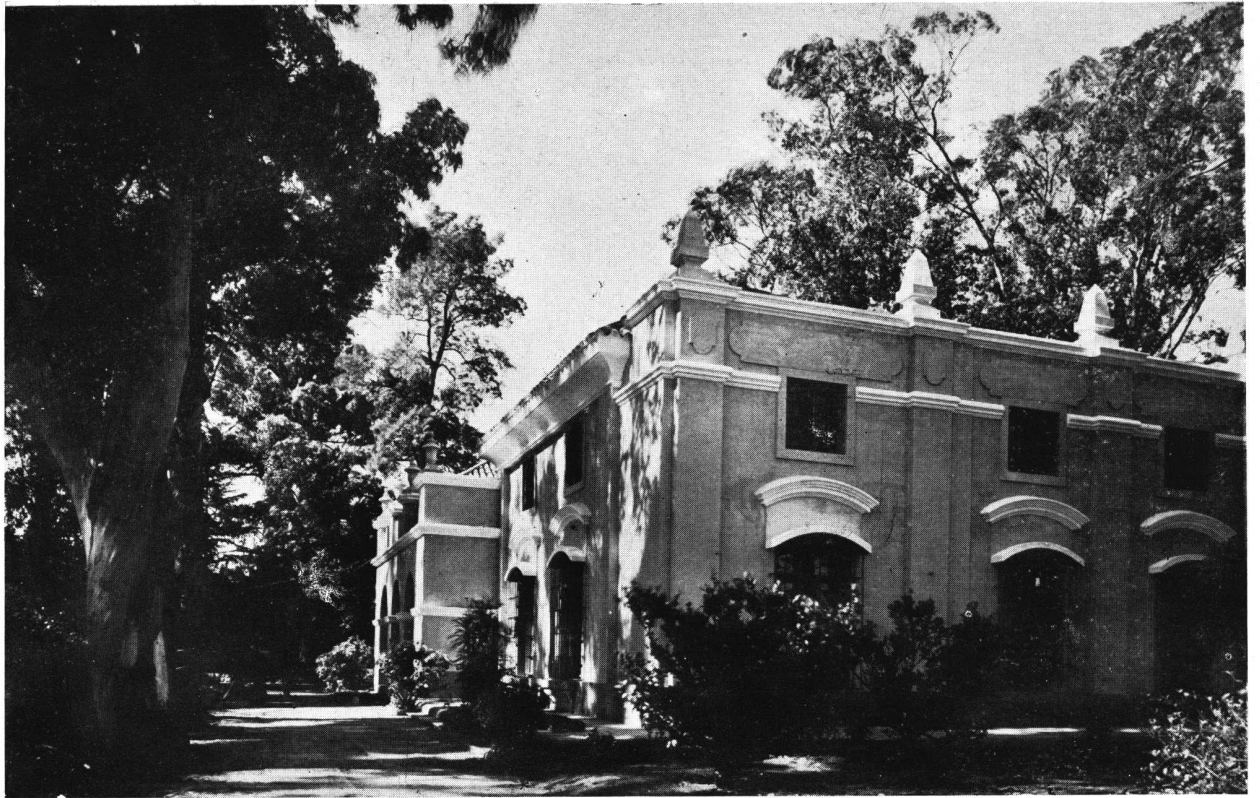
VISTA DEL ANGULO DE LAS FACHADAS LATERAL Y POSTERIOR
