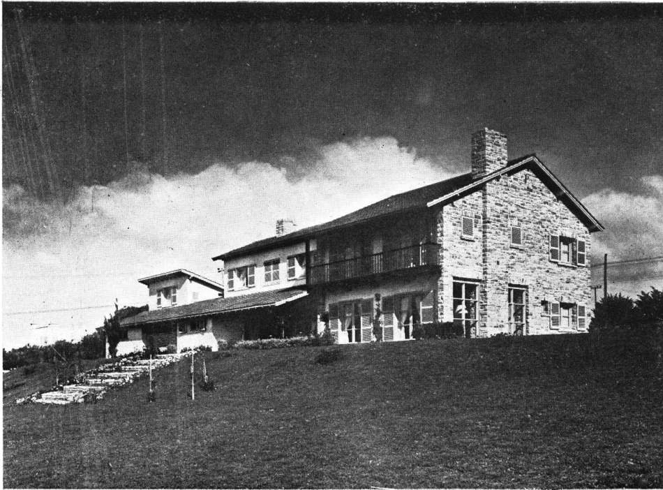
Terreno de una manzana. Fachadas en ladrillo aparente blanqueado y en piedra amarilla de la región con junta blanca. Techo de tejas Marsella. Carpintería de madera, pintadas color blanco. Balcón y parantes, galería de madera dura, barnizada. Jardín de pases de césped y escalera de piedra.
