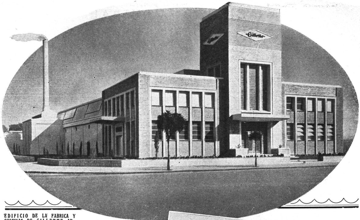
Un detalle de la chimenea del establecimiento, construída íntegramente de hormigón de cemento portland. La altura total de esta chimenea es de 25 metros.
