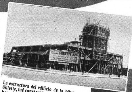
Un detalle de la chimenea del establecimiento, construída íntegramente de hormigón de cemento portland. La altura total de esta chimenea es de 25 metros.
