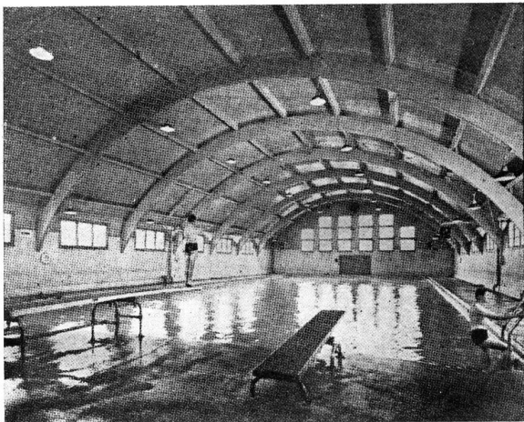
VISTA DE UNA PILETA DE NATACION CUBIERTA CON ARCOS DE CHAPAS ENCOLADAS
