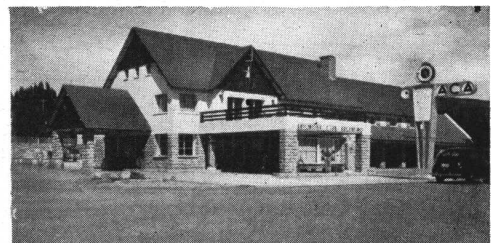
Estación de Servicio del Automóvil Club Argentino construida con cemento "San Martín", en San Carlos de Bariloche. - Arq. Sr. Antonio U. Vilar. Empresa Constructora, Christiani y Nielsen.
