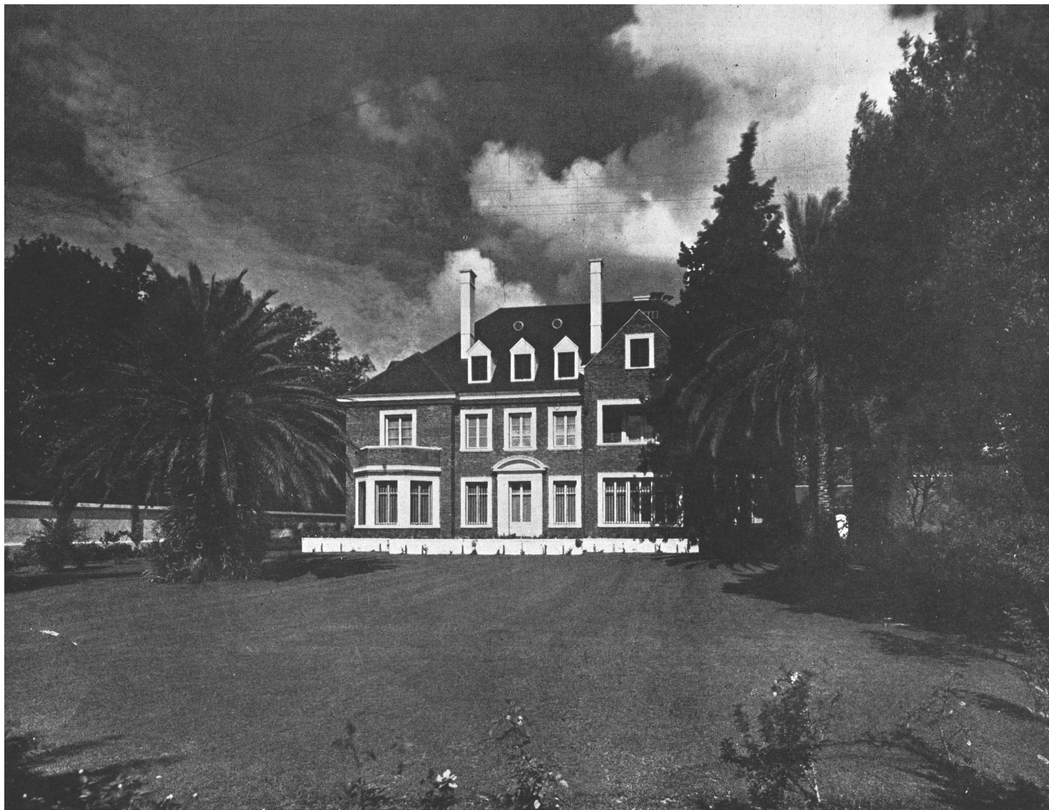
FACHADA AL JARDIN
