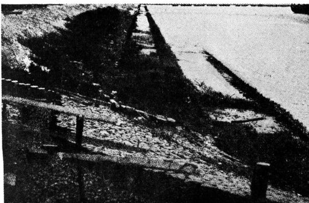
Fig. 15 — Recuadros con malezas para asegurar la base del dique.
