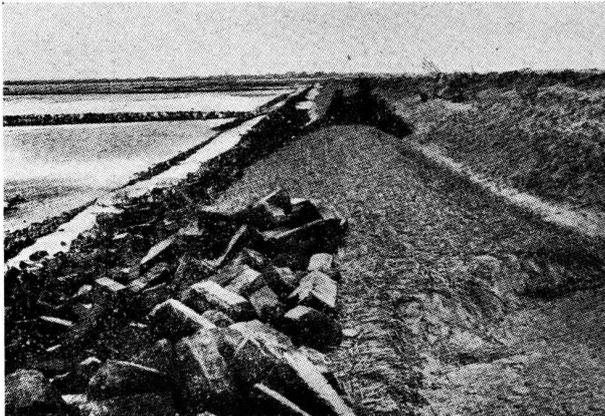
Fig. 13 — Resguardo provisorio de la orilla mediante trenzado de paja y piedras de basalto.
