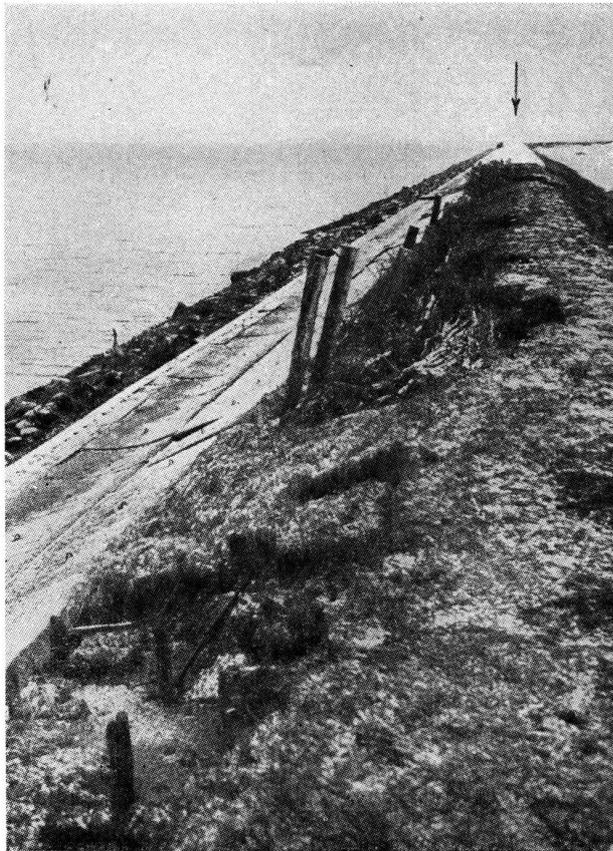
Fig. 5 — Cresta del dique dañada por la marea (al fondo la nueva capa de cemento).
