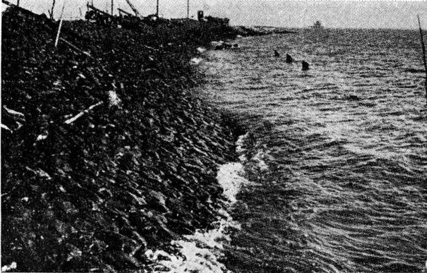
Fig. 11 — Dique de basalto para resguardar la orilla.
