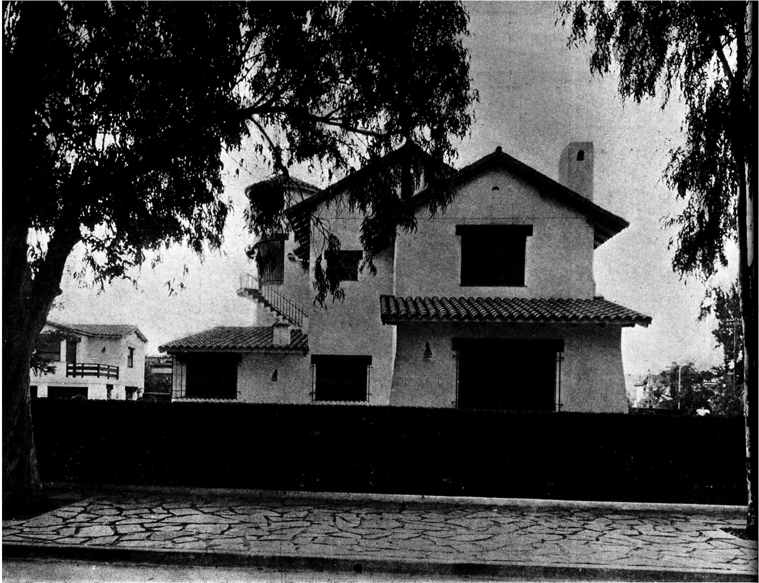
FRENTE A LA CALLE SARMIENTO (S. E.)
