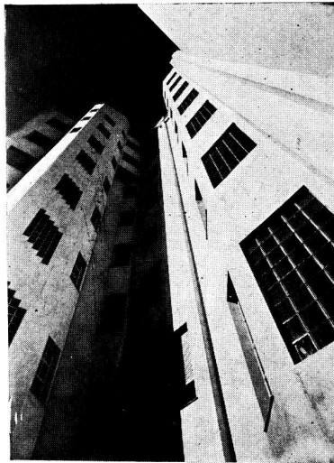
VISTA DEL PATIO
