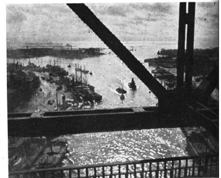
Perspectiva desde la parte superior del puente metálico
