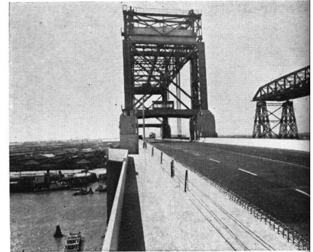
Calzada y pasarela de peatones a bajo nivel
