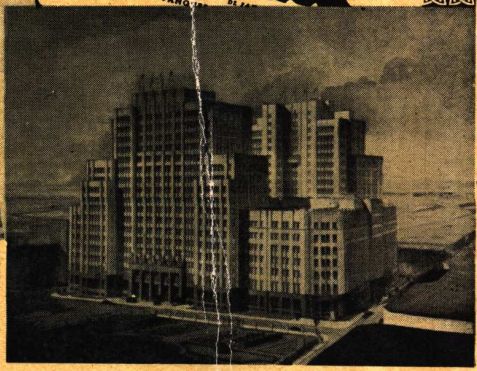
FACULTAD DE CIENCIAS MEDICAS DE LA UNIVERSIDAD DE Bs. As. En construcción
