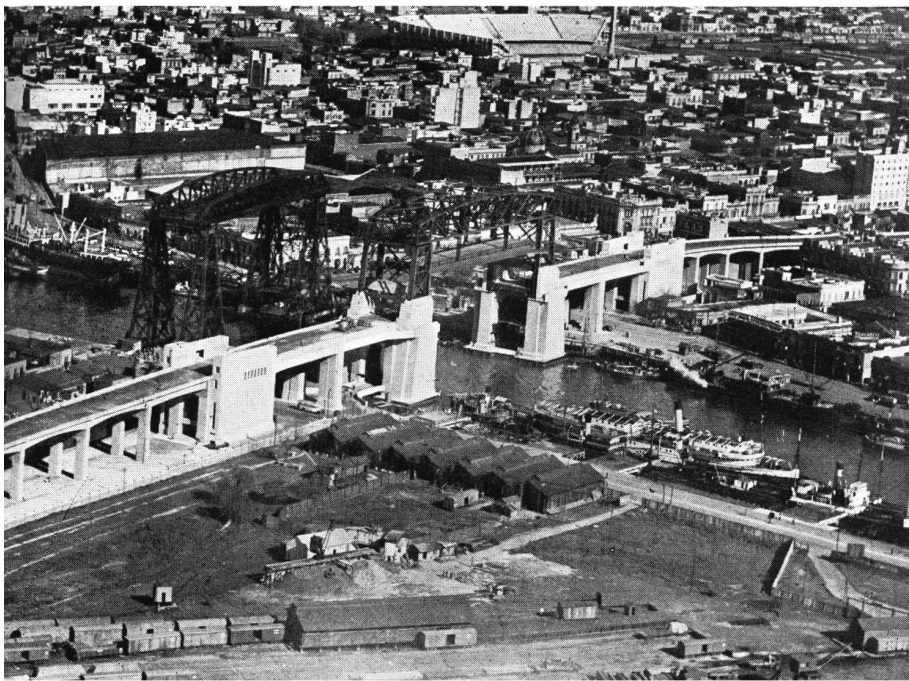
Vista del puente metálico con su calzada levantada para permitir el tránsito fluvial.
