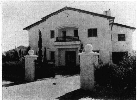
VISTA DE LA FACHADA SOBRE LA CALLE DESDE EL PORTON DE LA ENTRADA.
