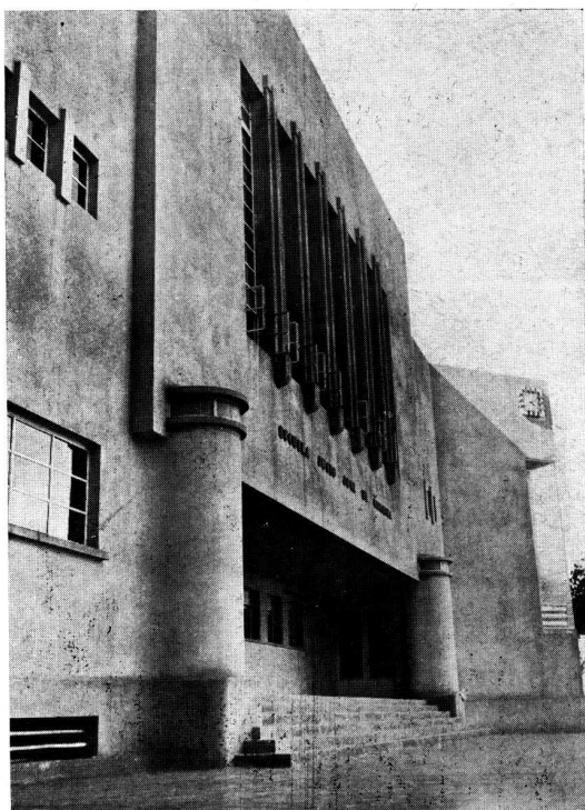
DETALLE DE FACHADA
