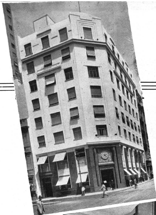
Frente del Edificio de la Transradio Internacional Compañía Argentina de Telecomunicaciones, S. A., Corrientes 500 (Capital).
