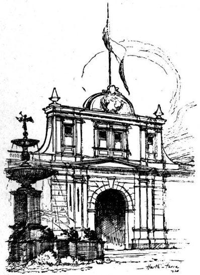
Puerta principal del antiguo Palacio de Gobierno, que reemplazó a la de la Rivera, y que dominaba la histórica pila de bronce de la Plaza de Armas
