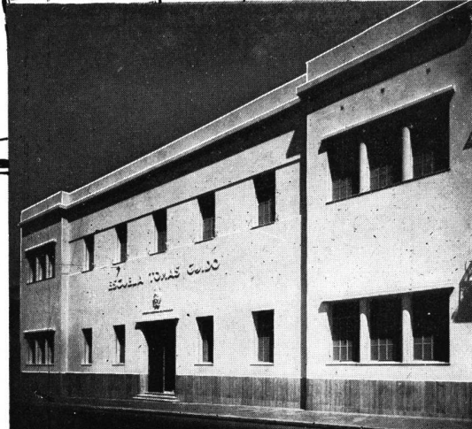
ESCUELA TOMAS GUIDO - SAN JOSE 1900 En esta obra se ha colocado techado asfáltico INTEC
