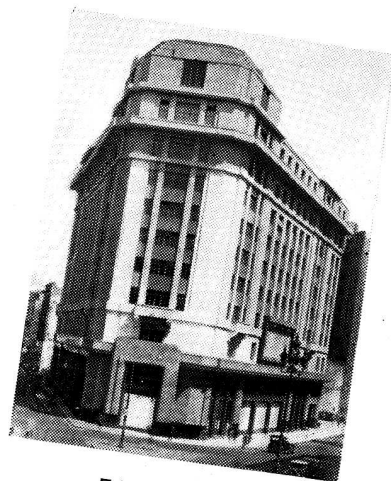
Edificio Volta Av. R. Sáenz Peña 812
