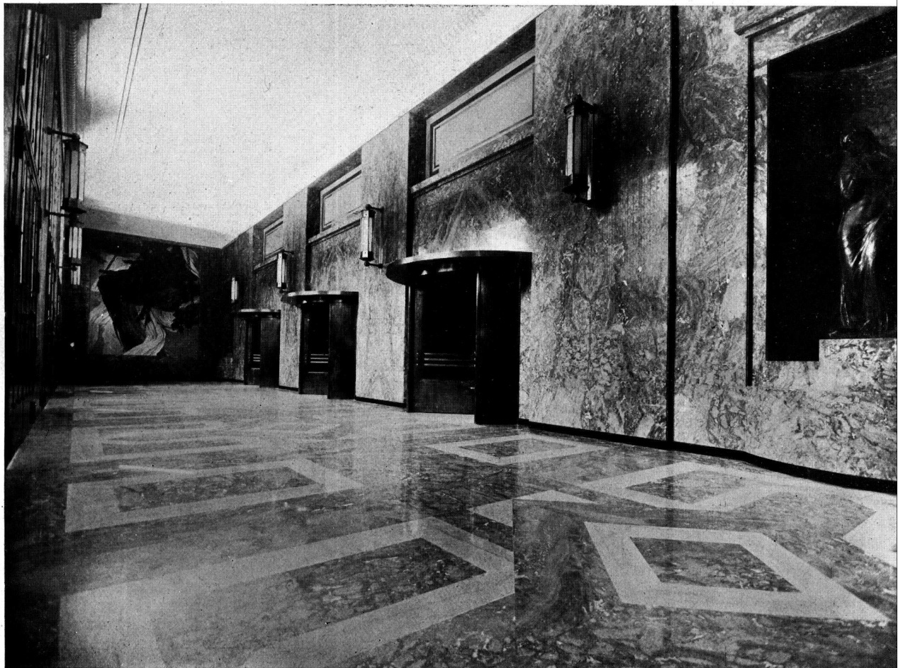
VESTIBULO DE ENTRADA SOBRE LA CALLE VICTORIA
