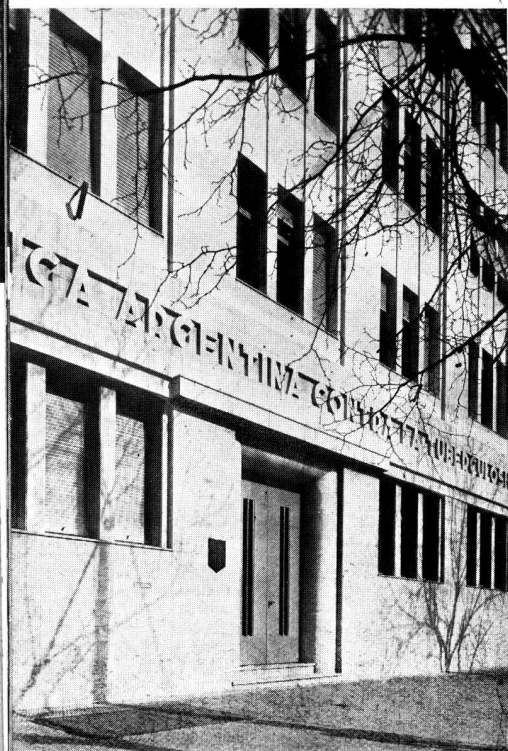
DETALLE DE FACHADA
