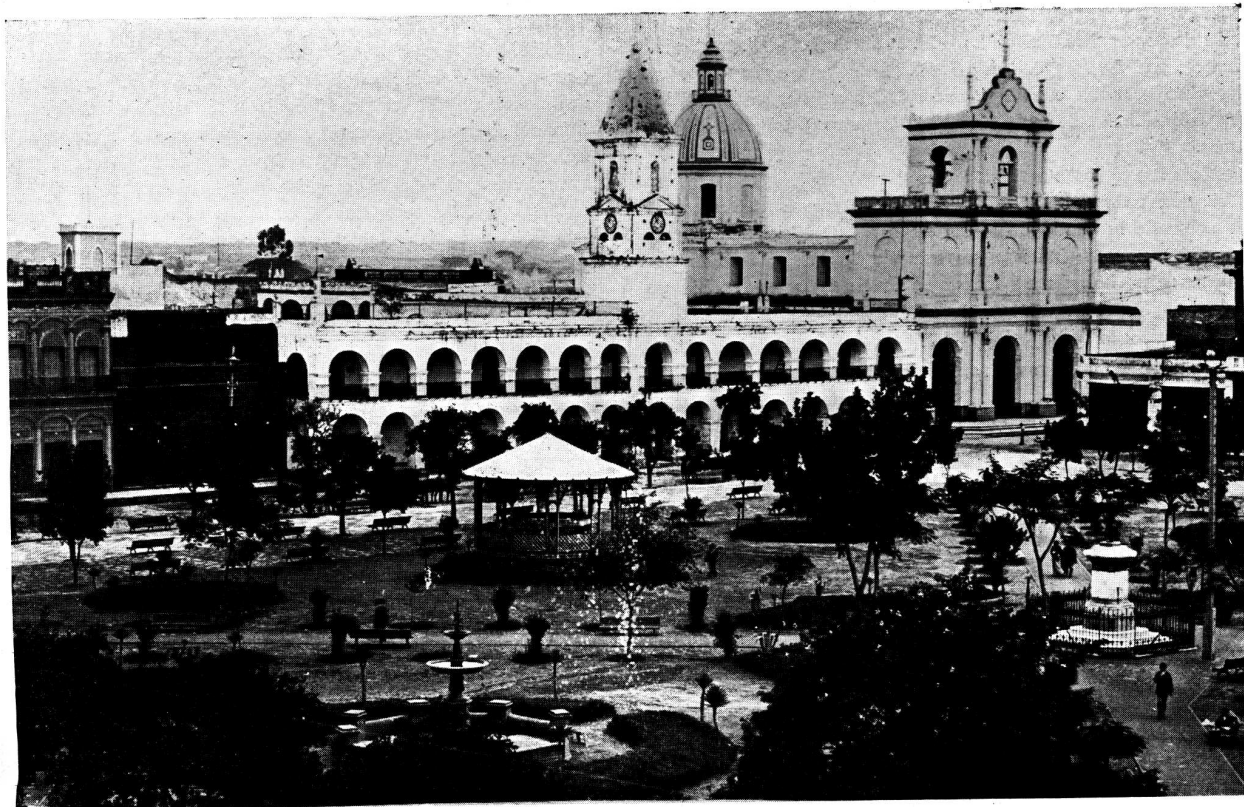
EL CABILDO DE TUCUMAN, DEMOLIDO PARA LEVANTAR EN SU SITIO LA CASA DE GOBIERNO
