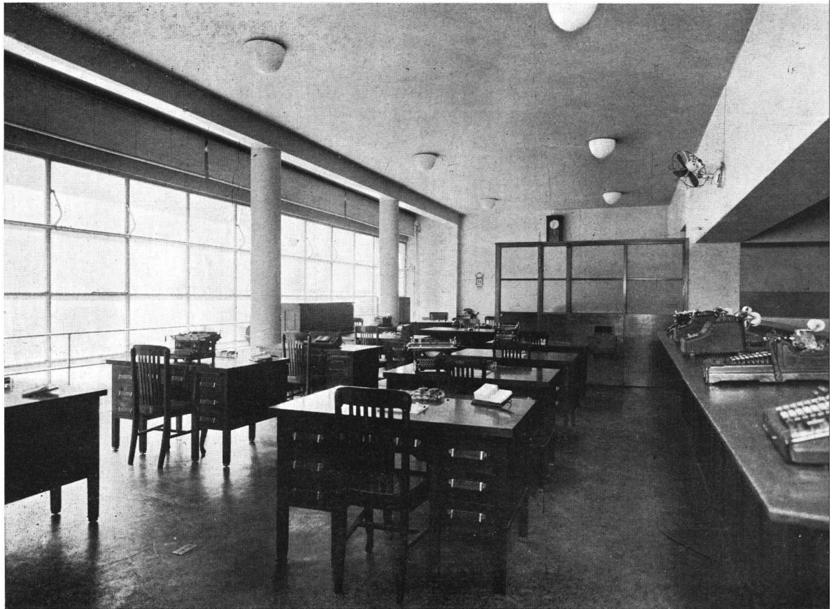
VISTA PARCIAL DE LA CONTADURIA
