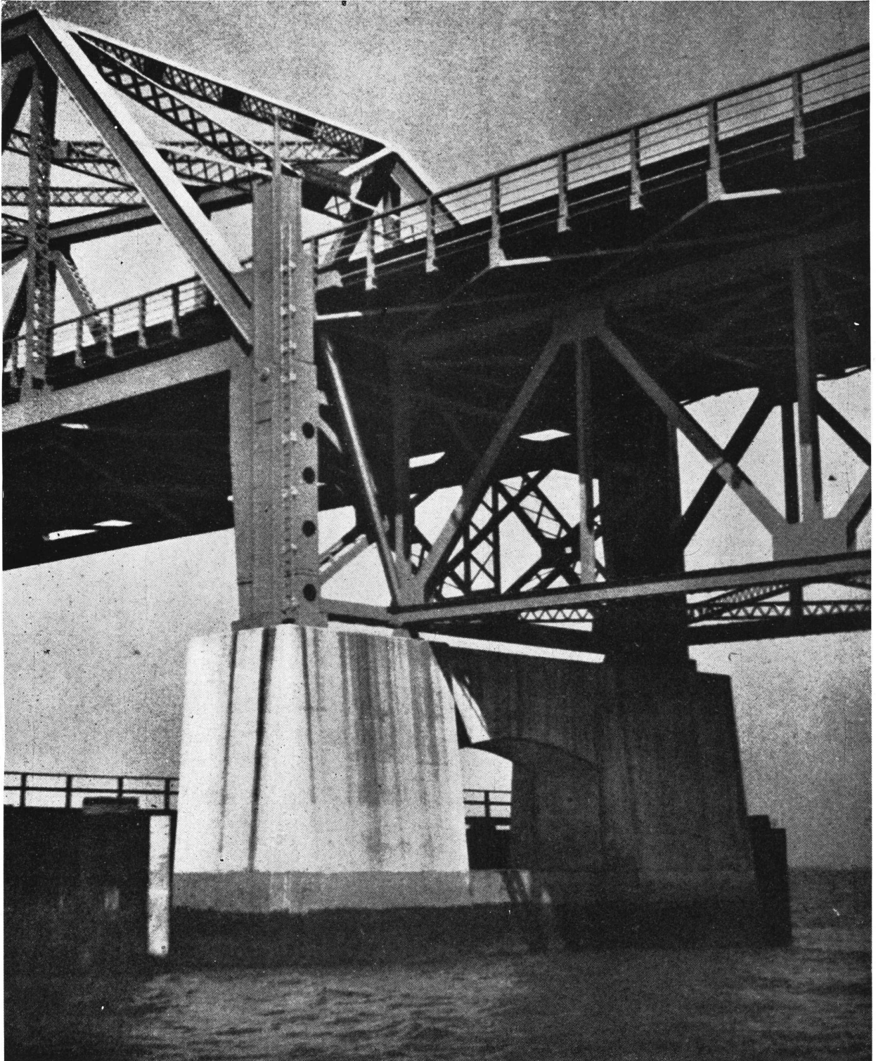
Los pilastres que sostienen el puente Marine Parkway, tienen superficies perfectamente lisas. Waddell y Hardesty fueron los Ingenieros y Aymar Embury II el Arquitecto.
