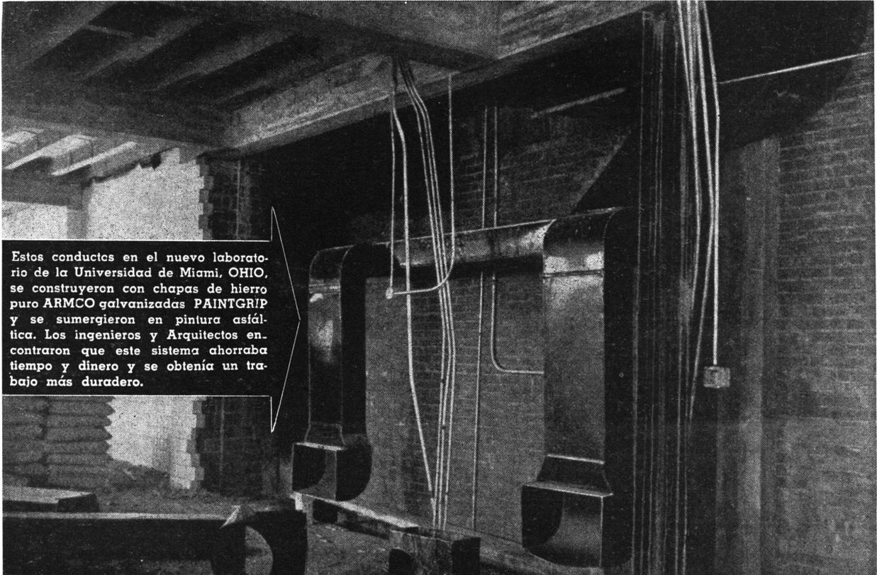
Estos conductos en el nuevo laboratorio de la Universidad de Miami, OHIO, se construyeron con chapas de hierro puro ARMCO galvanizadas PAINTGRIP y se sumergieron en pintura asfáltica. Los ingenieros y Arquitectos encontraron que este sistema ahorra tiempo y dinero y se obtenía un trabajo más duradero.
