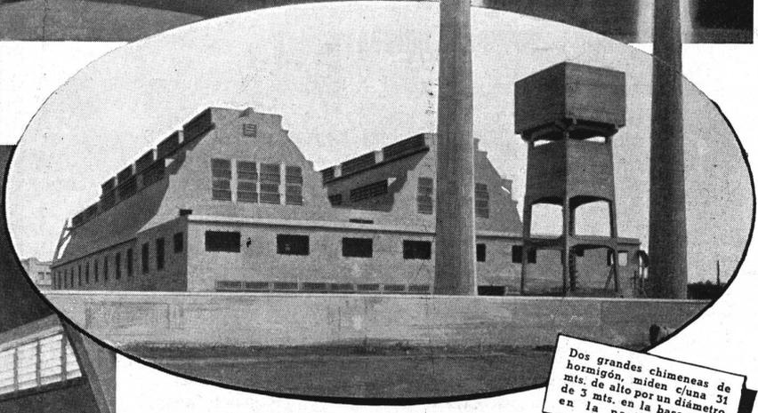
Dos grandes chimeneas de hormigón, miden cada una 31 de 3 mts. en la base y 1.30 en la parte superior.
