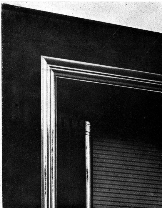
Aplicaciones decorativas de acero inoxidable en el Edificio Galería Florida, ejecutado por FREDK SAGE & Co. (S. A.) Ltd., bajo la dirección del Arq. A. J. Olivari.
