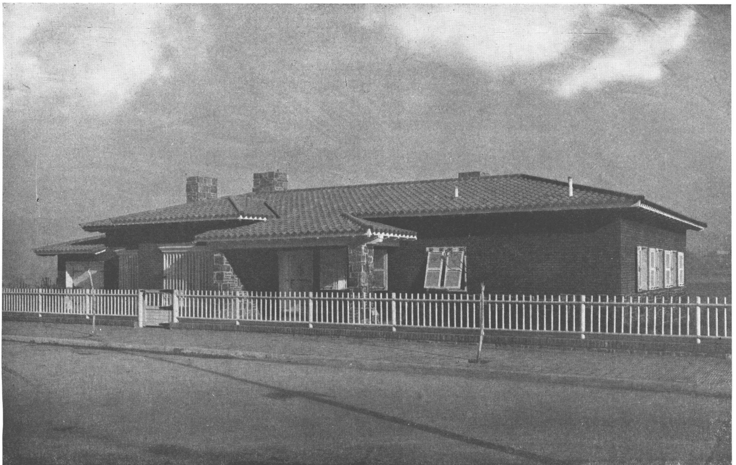
Fachada principal de la casa, propiedad de la Sra. Esther Nores de Avila Guevara, ubicada en la calle Segunda Lavalleja 1061. Puede apreciarse el contraste de las rejas de las ventanas y de la verja, con el rojo oscuro de los ladrillos aparentes y el verde del césped, formando así un conjunto alegre y atrayente.
