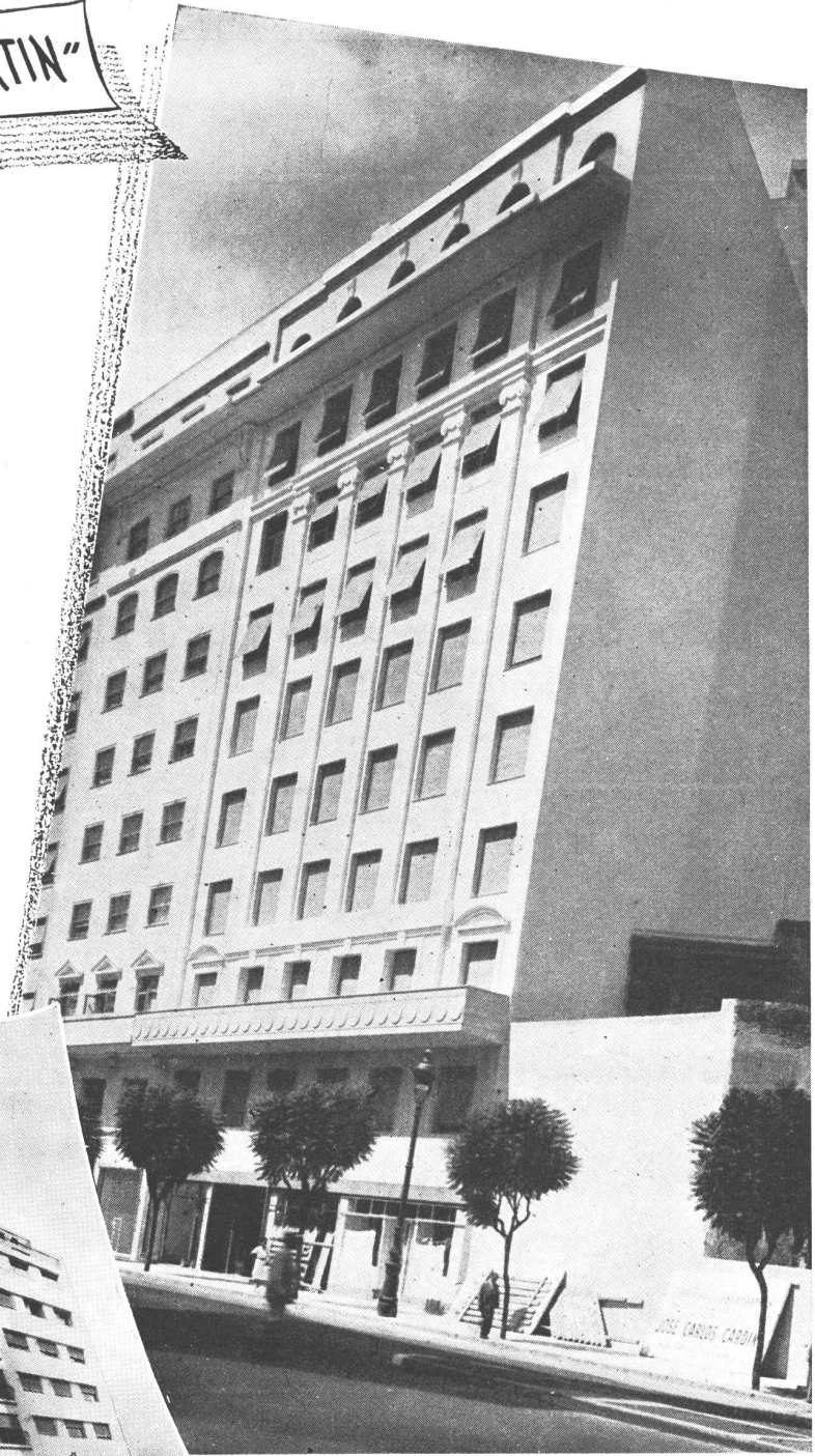
Av. Pte. R. Saenz Peña 1174, Capital. Proprietarios: Sres Domingo Geraci y Alfredo Rubinch. - Arquitecto: señor Juan Carlos Cardini. - Construcción y Hormigón Armado: señor Humberto Di Lorenzi.
