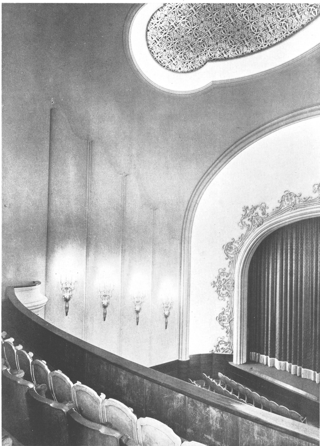
La boca de escena vista desde la Pullman; a cada costado, cuatro appliques en bronce cincelado y plaquetas de cristal. En el cielo-raso gran plafond de escultura calada, orlado por garganta con iluminación difusa.
