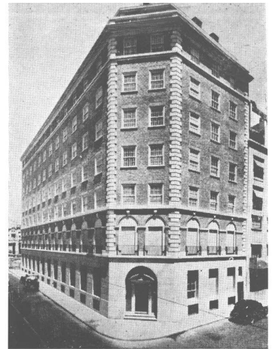
OBRA: Hotel Lancaster - Capital. Arqs. Acevedo, Becú y Moreno. Emp. Const. Ing. Carlos Agote
