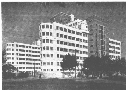
OBRA: Hospital Argerich. Municipalidad de la Ciudad de Buenos Aires. Arq. Emilio Rubillo Emp. Const. Antonio D'Elía.
