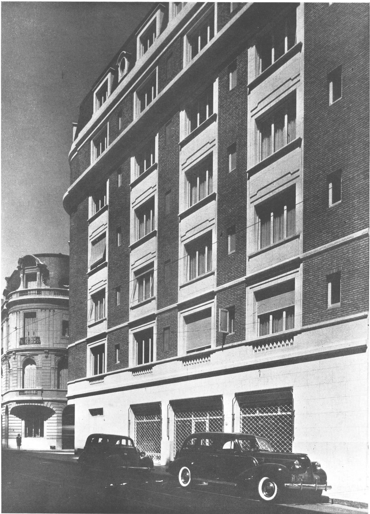
La fachada sobre la calle Uruguay.
