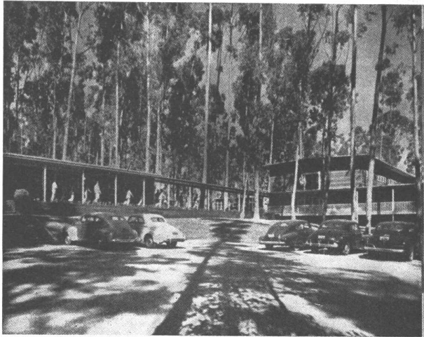
Escuela para cadetes de la Marina americana, proyectada por el Arq. Gardner A. Dailey. Se trata de una construcción de emergencia proyectada de acuerdo a la topografía del terreno.
