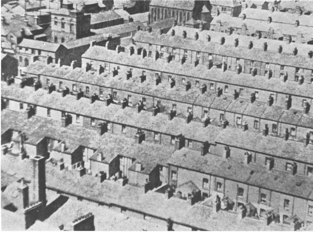
En el siglo XIX, kilómetros y kilómetros de tierra en Gran Bretaña fué cubierta con casas monótonas y carentes de vida, como éstas.
