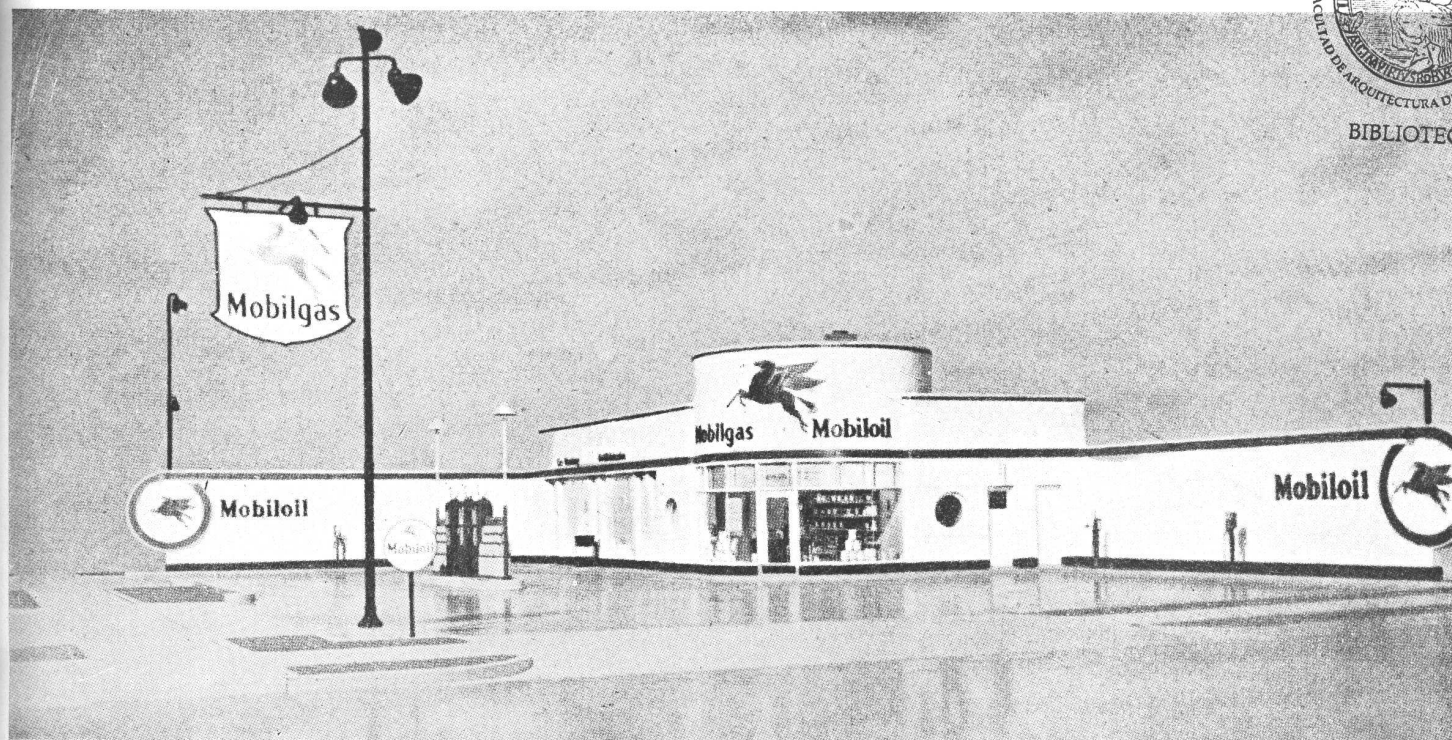
Un modelo avanzado de estación de servicio actualmente en uso. El "tambor" que da forma a la parte central del edificio es distintivo de una marca. El terminado es en esmalte y la construcción hecha a base de elementos standardizados.
