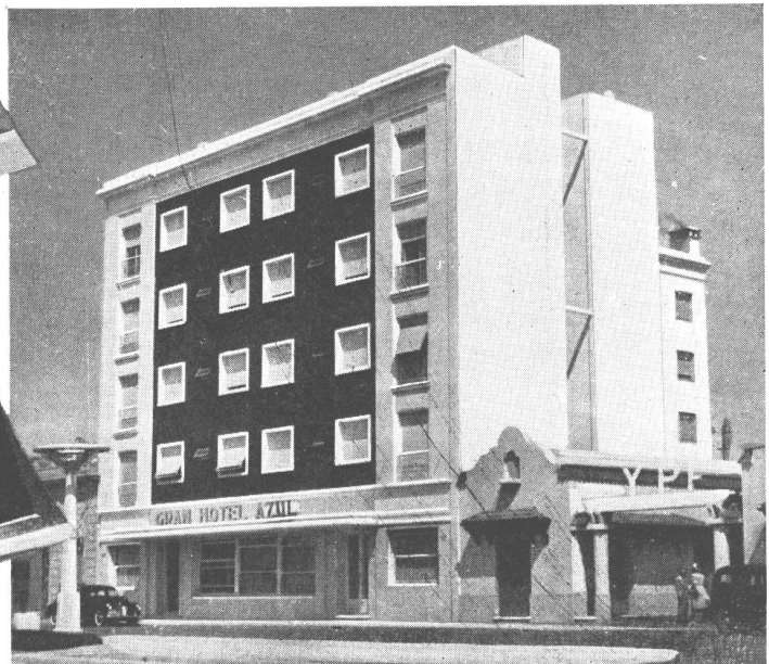
Colón entre Alsina y San Martín. - Propietario: Gran Hotel Azul S. A. - Arquitectos: señores Blas J. Diers y Hugo Garbarini. - Constructores: señores Toscano, Lattanzi y Barbetti.
