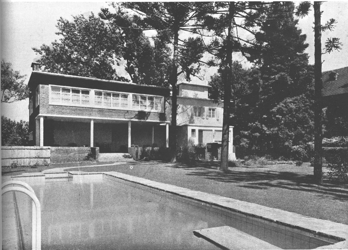
La fachada sobre el jardín del fondo. La casa está situada en la calle Liniers 752
