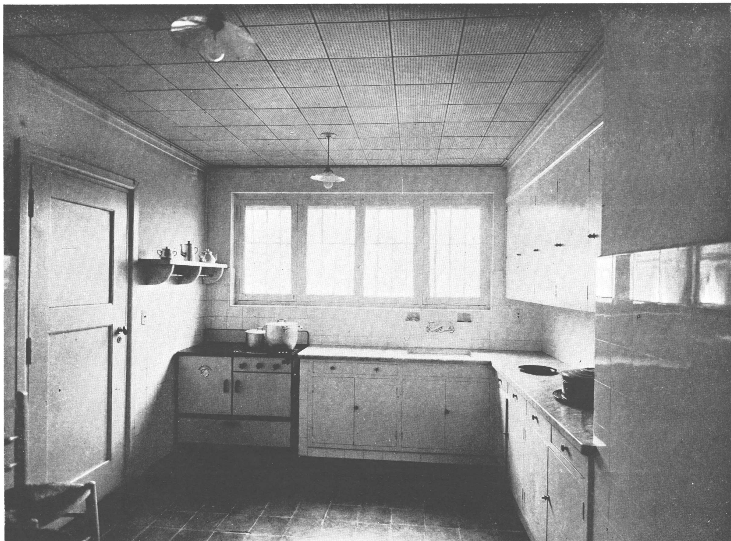
La cocina con cielo raso de material aislante del sonido
